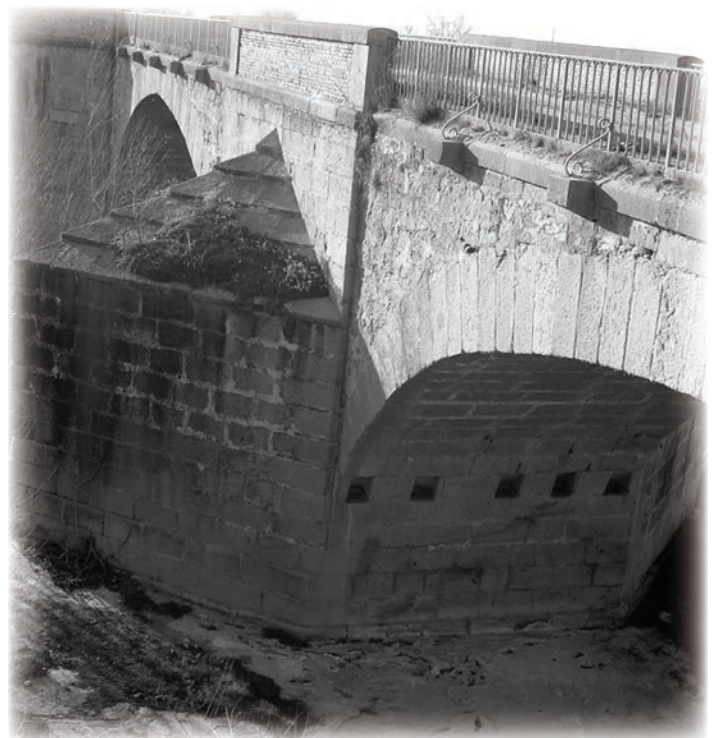
Puente sobre el Río Tajo a su paso por La Puebla de Montalbán
