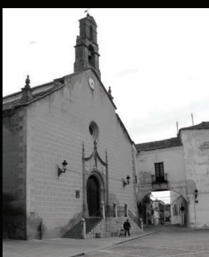
Estado actual en que se encuentra la fachada de la Iglesia Parroquial de Ntra. Sra. de la Paz
