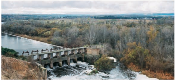
Vista de la presa desde el Oeste con la el Soto de Gramosilla y la Rinconada
