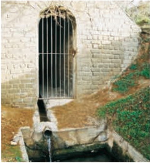
Mina de Agua
