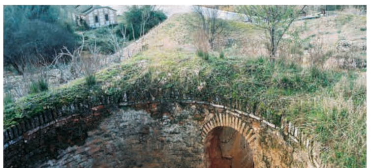
Interior del horno con la Casa de Gramosilla al fondo
