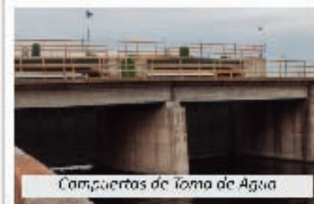
Bocal Toma de Agua Canal
