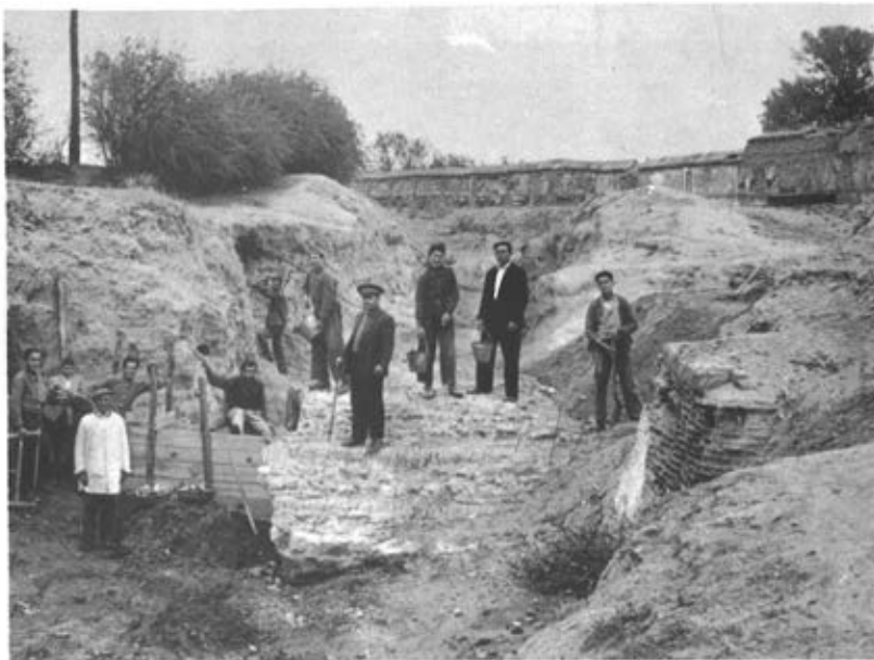
Enorme socavón producido por la erosión de las aguas en el lugar que ocupaba la presa levantada en el Arroyo de detrás de las Huertas, próximo al convento de franciscanos, y que impedía el paso de personas de animales y de toda clase de carruajes. La presa fue construida de nuevo el año 1959 por el maestro de obras Emilio Sánchez Medina que aparece en la fotografía, junto con los peones que trabajaban a sus órdenes y el inspector municipal Sixto Martín Urda.
