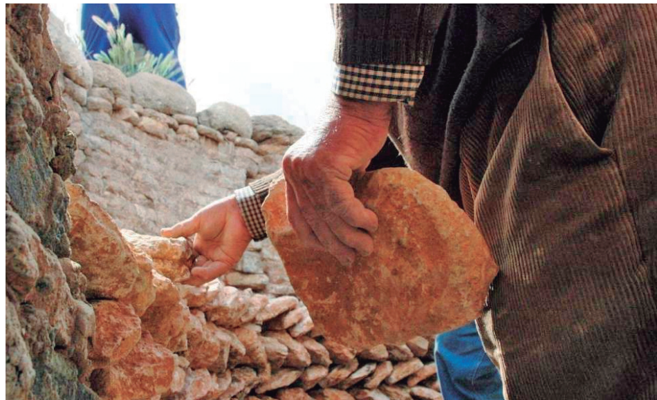
Detalle de la colocación de las piedras calizas en el horno
