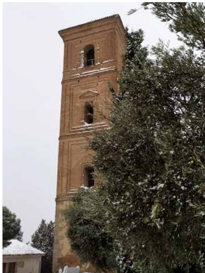
Torre de San Miguel. 2021. Autoría propia.
