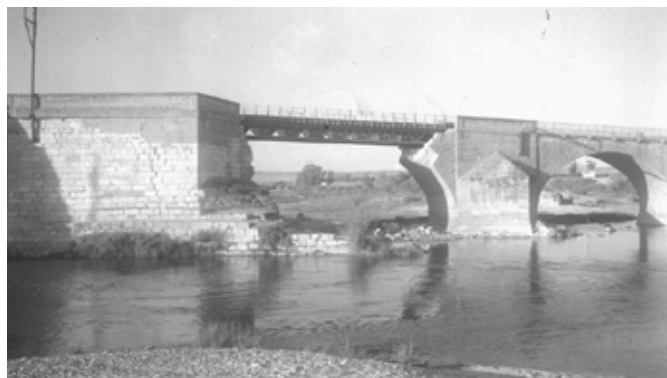
Puente sobre el río Tajo en La Puebla de Montalbán. Arco volado provisto de un puente provisional tras finalizar la Guerra (AHEA, 1-13751-01).
