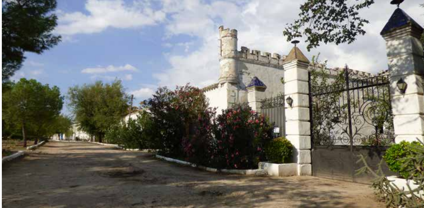
Fachada exterior del palacio de Alcubillete. Elaboración propia.
